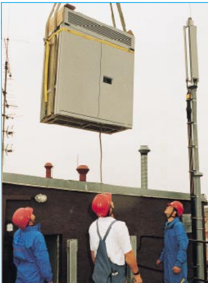
Bild 2: Die VIAG setzt auf die intelligente Verbindung von Mobil- und Festnetz. Hier die erste Feststationsmontage für das neue E2-Netz. Foto: VIAG
