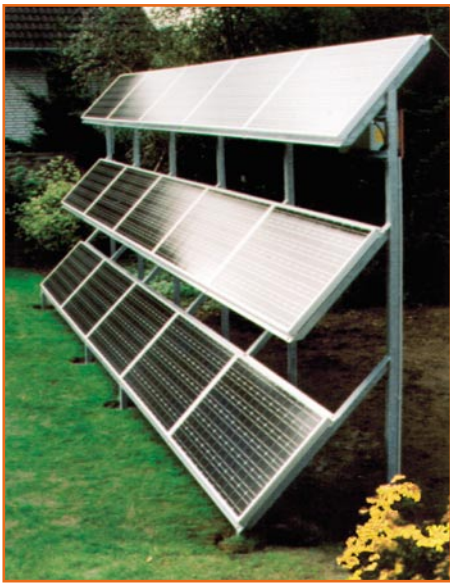
Bild 5: Auch eine Freiaufstellung, etwa auf dem Flachdach oder im Garten ist dank flexibler Halteelemente für die Solarzellen kein Problem und manchmal die nach außen hin ansprechendere Lösung. Foto: Solar-Technik Nord
