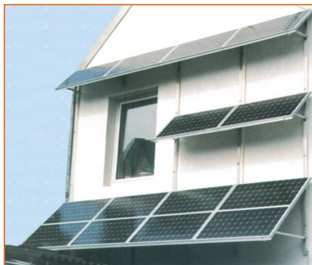
Bild 4: Keine Dachfläche Richtung Süden? Kein Problem - die Fassadenmontage ist genauso möglich. Foto: Solar-Technik Nord
