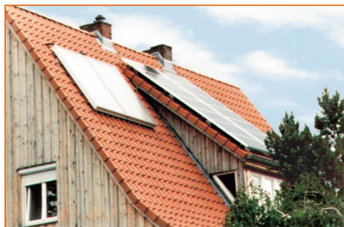
Bild 3: Wie flexibel sich Dächer für eine Solaranlage nutzen lassen, zeigt dieses Ausführungsbeispiel einer kombinierten Solarstrom- und Solarthermieanlage. Foto: Solar-Technik Nord
