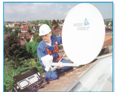
Bild 21: Gegen Absturz sichern!
