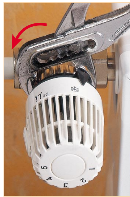
Bild 2: Demontage des mechanischen Heizkörperthermostaten
