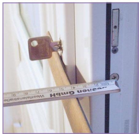
Bild 1: Die Maße des erforderlichen Schließzylinders sind einfach zu ermitteln.
