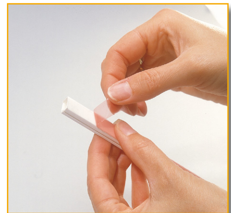
Bild 3: Entfernung der Schutzfolie vom Installationskanal
