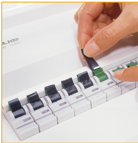
Bild 5: Befestigung der Magnete mit Hilfe von Klebeband
