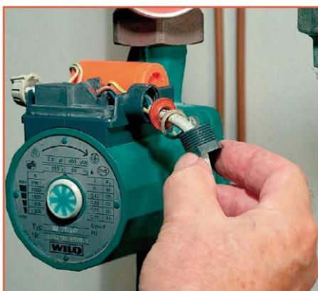
Ziehen Sie aus dem Innengewinde der Verschraubung die Kabel-Gummiabdichtung heraus.
