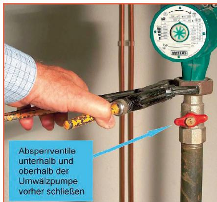
Schließen Sie die Absperrentile (Wasserhähne), die vor und hinter der Umwälzpumpe angebracht sind. Schrauben Sie anschließend mit einer größeren Wasserpumpenzange oder mit einem großen Rollgabelschlüssel die alte Pumpe an ihren beiden Enden ab.
