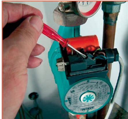
Bevor Sie das Anschlusskabel losschrauben, notieren Sie sich die Reihenfolge der Anschlüsse. Lösen Sie dann die Anschlussklemmen und ziehen Sie das gelöste Kabelende aus dem Pumpengehäuse heraus.
