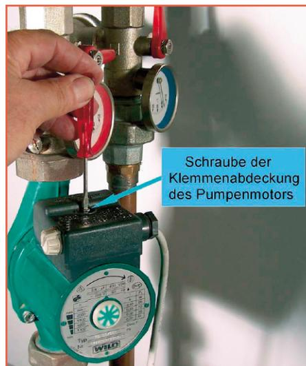
Schraube der Klemmenabdeckung des Pumpenmotors
