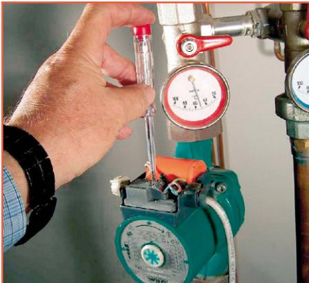
Überprüfen Sie mit einem Phasenprüfer, ob die Stromanschluss-Klemmen der Pumpe tatsächlich spannungsfrei sind.
