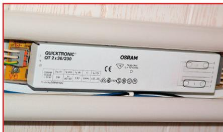
**Bild 1: Passen in alle gängigen Lampengehäuse – elektronische Vorschaltgeräte**
