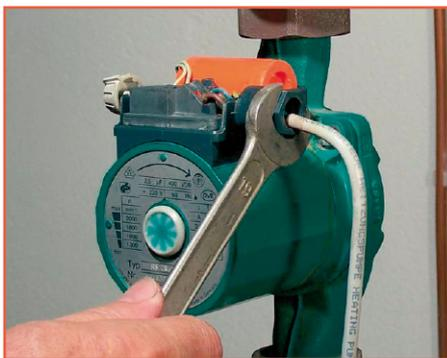
Drehen Sie mit einem Gabelschlüssel die Kabelanschluss-Verschraubung am Pumpenmotor heraus.
