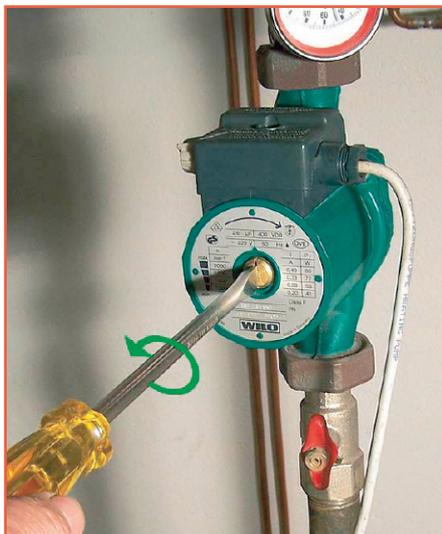
Die jetzt zugängliche Messingschraube ist mit einem Schlitz für einen Schraubendreher versehen und dient vor allem zum Entlüften der Pumpe bei erster Inbetriebnahme. Bevor Sie die Schraube heraus-schrauben, müssen Sie die beiden Absperrventile an beiden Seiten der Pumpe schließen (ansonsten fließt Heizungswasser ungehindert heraus).
