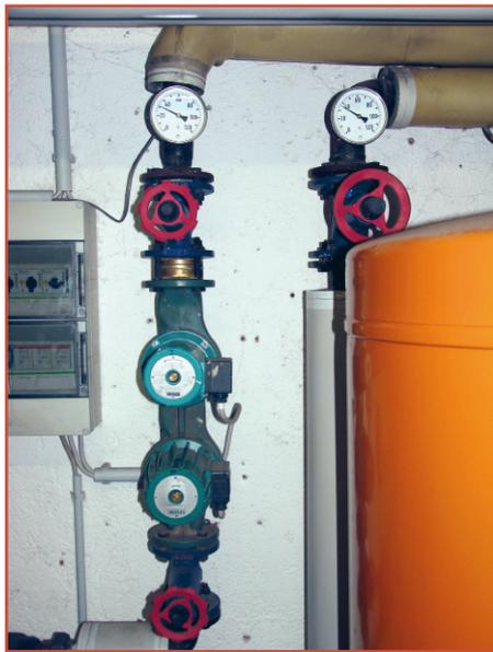
**Bild 1: Umwälzpumpen im Heizungskeller – hier wird oft unnötig viel Strom verbraucht.**
