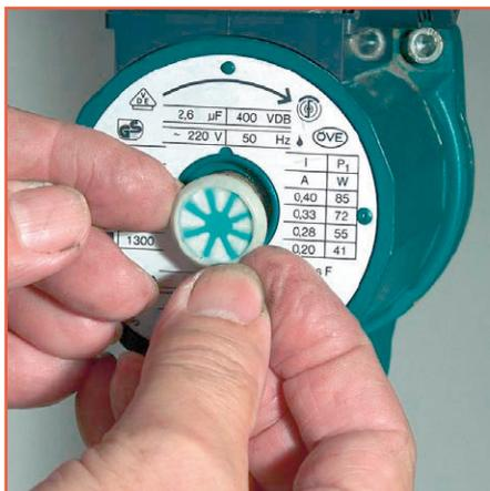
Auf der Pumpenwelle befindet sich eine Schraube (Messingschraube), die üblicherweise mit einer runden, flachen Kunststoffkappe abgedeckt ist.
