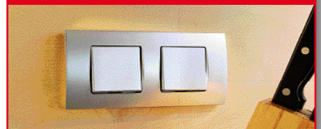
Bild 11: Man sieht ihr das Innenleben nicht an – unsere fertige Batterie-Funksender-Kombination für den Einsatz im Nassbereich der Küche. Achtung, diese Installation ist nicht spritzwassergeschützt, aber ungefährlich für das Bedienen mit nassen Händen.
