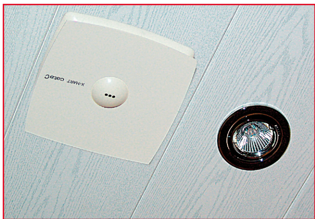
Bild 16: Ein solcher Deckenlüfter mit automatischer Abdichtung fügt sich hervorragend auch in Wohnumgebungen ein und fördert genug Luft, um auch größere Räume schnell zu entlüften.
