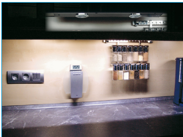
Bild 1: LED-Stripes in Aktion. Man erkennt deutlich die erreichte hohe Helligkeit der hier betriebenen LEDs. Die vormals als reguläre Arbeitsleuchte installierte Halogen-Leuchte ist abgeschaltet (siehe Einblendung)! Wird die LED-Leuchte nicht wie hier direkt an der Schrankblende, sondern weiter davon entfernt montiert, kann die gesamte Arbeitsfläche ausgeleuchtet werden.
