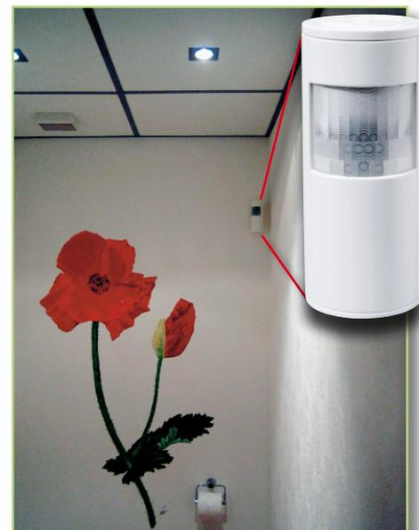
**Bild 5: Der FS20 PIRI „regelt“ über einen FS20 SH im Schaltschrank das Schalten von Licht und Belüftung in der Kundentoilette.**
