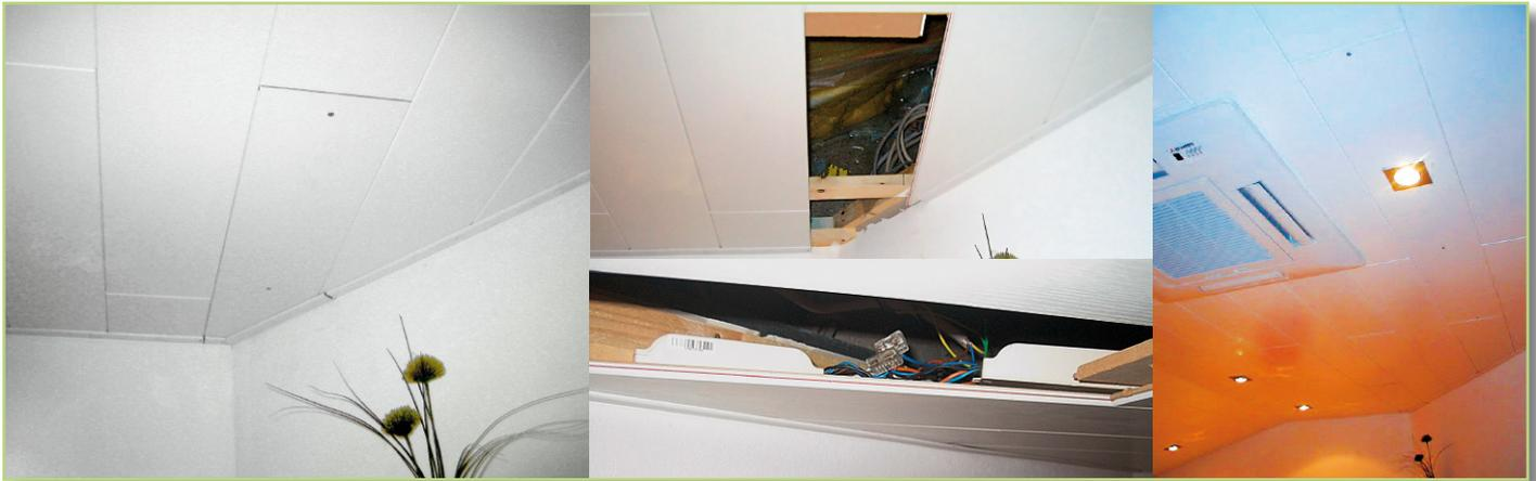
**Bild 2: Unauffällig installierte Wartungskappen ermöglichen einen leichten Zugang für Wartungs- und Programmierarbeiten. Lösung: einfach bei den Paneelen die oberen Teile der Nuten abschneiden, Panel einsetzen und die Paneele anschrauben. Die Schrauben sind mit farblich passenden Abdeckungen kaschierbar.**
