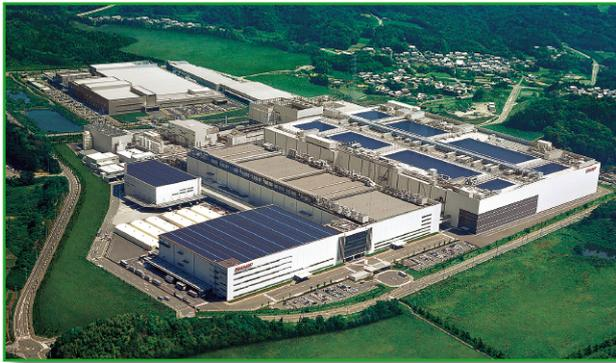
**Bild 8: Kameyama: LCD-Werk der Superlative in der japanischen Präfektur Mie. Auf 330.000 m<sup>2</sup> werden hier „System-LCDs“ auf Glassubstraten von 1500 x 1800 mm hergestellt – über 12 Millionen aller Größenordnungen pro Monat. (Quelle: Sharp)**
