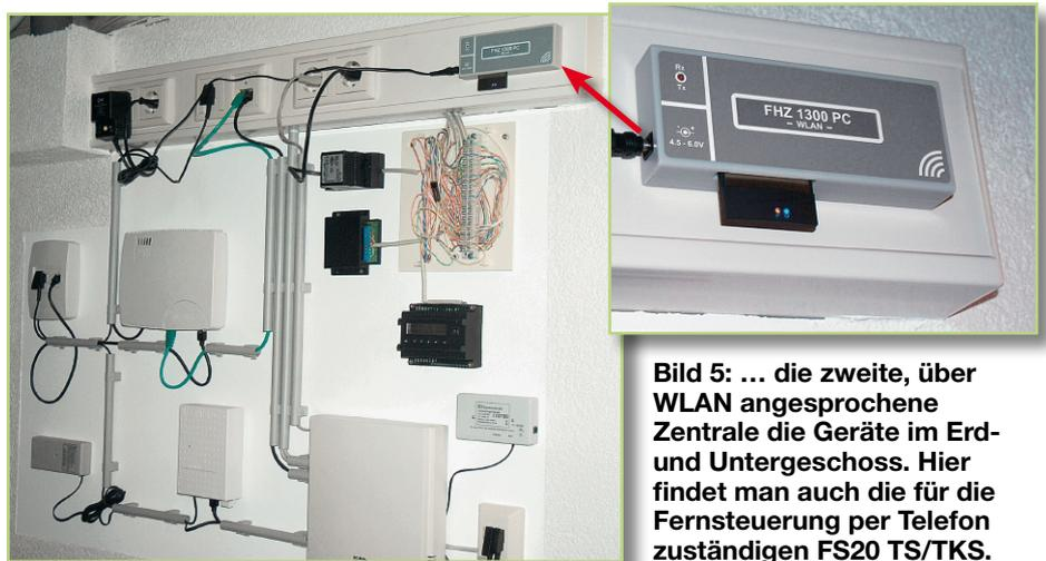
**Bild 5: ... die zweite, über WLAN angesprochene Zentrale die Geräte im Erd- und Untergeschoss. Hier findet man auch die für die Fernsteuerung per Telefon zuständigen FS20 TS/TKS.**
