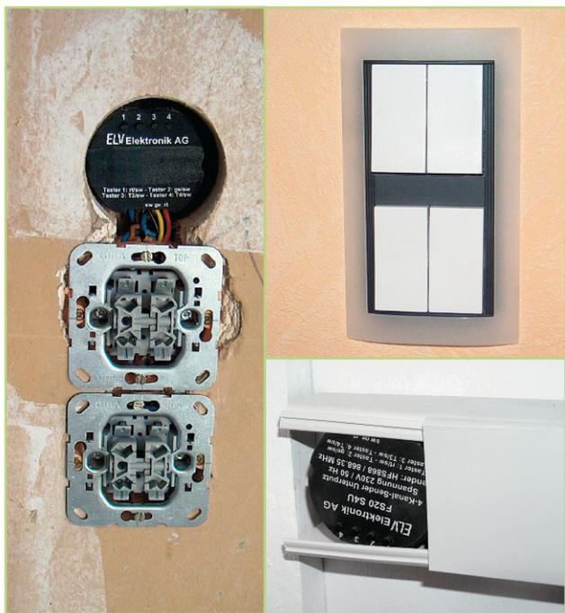
**Bild 2: Die Unterputz-Sender können auf die verschiedenste Art und Weise montiert werden, hier über einer 2x2fach-Tasterkombination, bei der später (rechts oben) nichts mehr an die dahinter steckende Technik erinnert. Rechts unten die Montage in einem Kabelkanal.**
