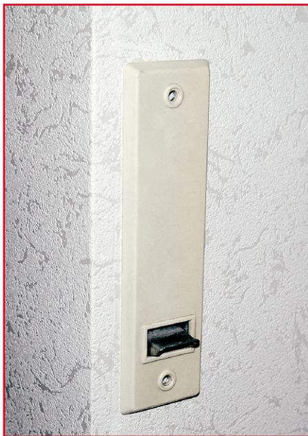
Bild 2: Hat ausgedient – die Abdeckung des Hand-Gurtwicklers
