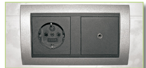
Bild 16: Mittels Blindplatte und Klinke selbstgebaute Multimedia-Dose für Ein- und Ausgabe
