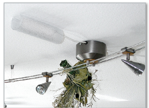
Bild 2: Die Funk-Dimmer sind in einer gefälligen Lochblech-Abdeckung untergebracht.
