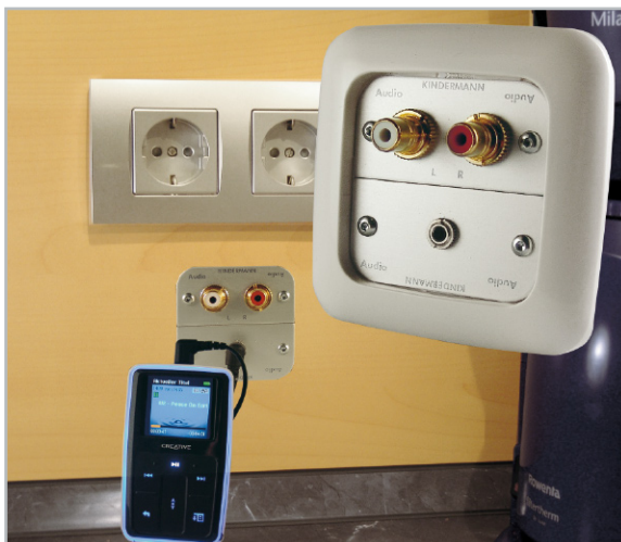
Bild 7: Über die Media-Dose können externe Audioquellen bequem angeschlossen werden. Hier wurden aus optischen Gründen nur die Einsätze ohne Abdeckung montiert.
