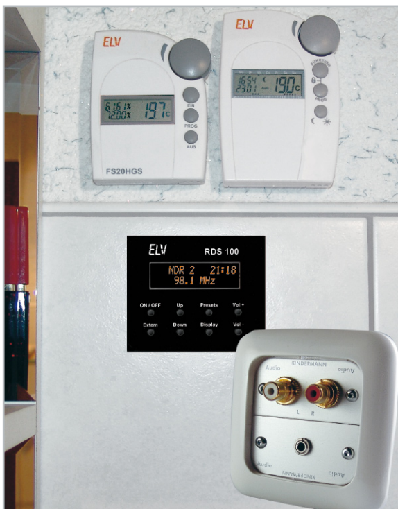
Bild 10: Perfekte Installation als Unterputz-Version. Bei Bedarf kommt auch hier die Media-Dose hinzu.
