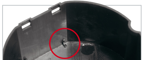
Bild 4: Modifikation der Unterputzdose: Die gekennzeichnete Gehäusenseite ist wie hier gezeigt abzuschneiden.
