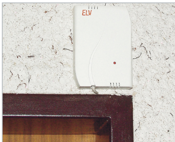
Bild 4: Der Zentral-Empfänger wurde im Nebenraum der Heizung untergebracht. Er war hier empfangsgünstig unterzubringen.
