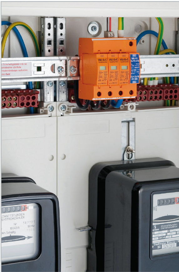
Bild 4: Ein moderner Blitzstromableiter als Kombigerät mit Überspannungsableiter, hier der V50B+C von OBO-Bettermann, unmittelbar am Zähler montiert. Bild: Pressebild OBO-Bettermann.
