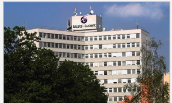
Bild 10: Standpunkt der Sektorantennen des LTE-Testnetzes
