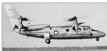
Bild 1: Urvater und Vorbild für die Multikopter: die Curtiss-Wright X-19. (Quelle: [1])
