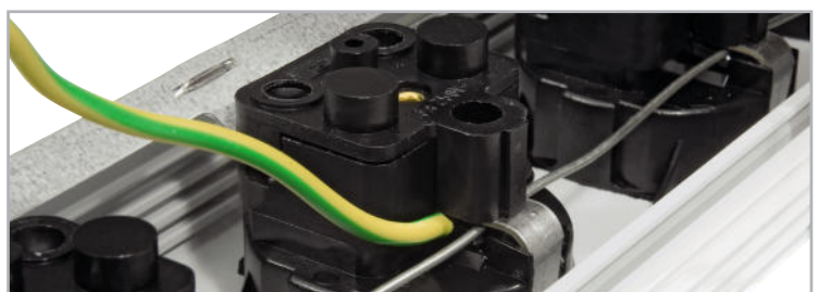
Bild 23: Der Schutzleiter wird an der ersten schwarzen Steckdose angeklemt.
