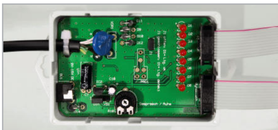
Bild 5: Hier sieht man die Fixierung des Telefon-Anschlusskabels mit einem Kabelbinder und rechts das Herausführen der Flachbandkabel aus dem Gehäuse.
