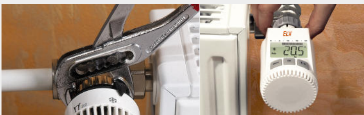
Bild 1: Der Umbau dauert keine 5 Minuten: alter Thermostat ab, neuer dran! Kein Ablassen von Wasser, kein Schmutz!
