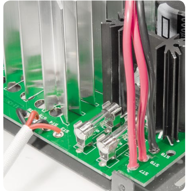
Bild 22: Anschluss der sekundärseitigen Trafoleitungen
