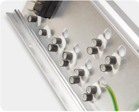
Bild 11: Aufsetzen der Schrumpfschlauchabschnitte zur Verhinderung der Lichtstreuung
