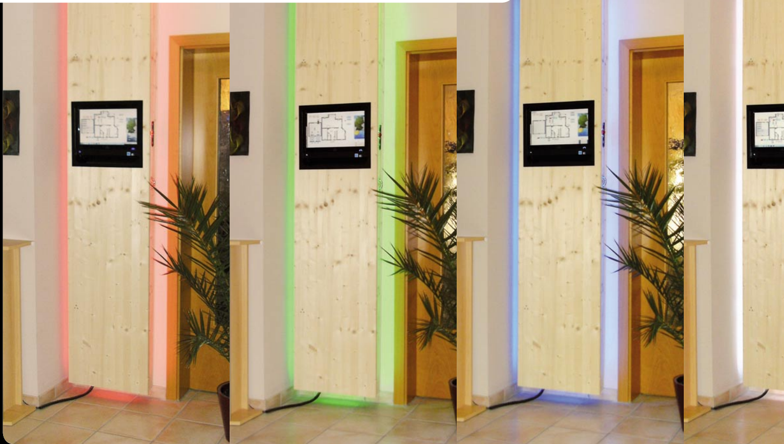
Bild 1: Fast schon ein Designobjekt – das Holzpanel trägt neben dem zentralen Touch-Screen-Monitor des Haustechniksystems seitlich die RGB-LED-Leisten.
