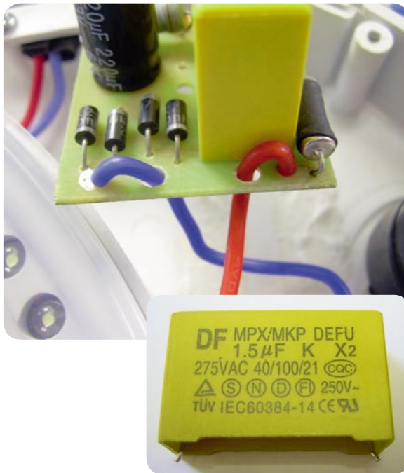
Bild 14: Minimalsicherung der Leitungsenden und X2-Kondensator, das geht in Ordnung.
