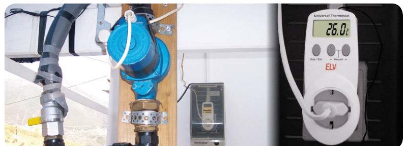
Bild 2: Der Universal-Thermostat UT 200 (hinten im Bild in einer wetterfesten Box) steuert die Wasserpumpe: Sobald am Solarkollektor eine Temperatur ab 28 °C gemessen wird, wird der Wasserkreislauf gestartet. Sinkt die Temperatur auf unter 26 °C, geht die Pumpe aus.
