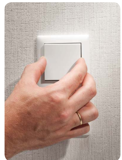
Bild 17: Abschluss der Installation: Einsetzen der Tasterwippe
