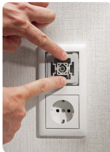
Bild 16: Der Abdeckrahmen des Installationsystems wird aufgesetzt.
