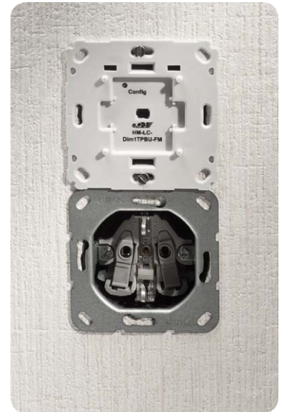
Bild 15: ... wird in die Installationsdose eingesetzt und verschraubt.
