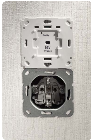
Bild 21: ... wird in die Installationsdose eingesetzt und verschraubt.
