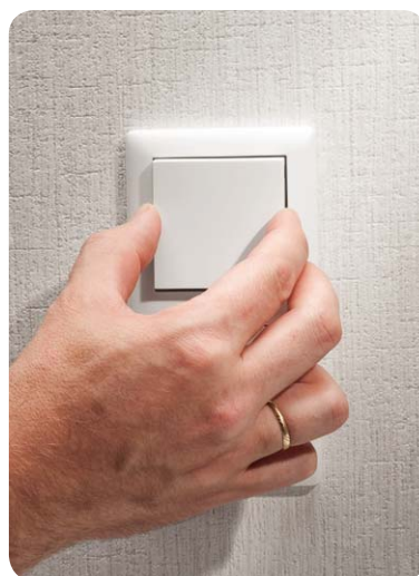
Bild 23: Abschluss der Installation: Einsetzen der Tasterwippe
