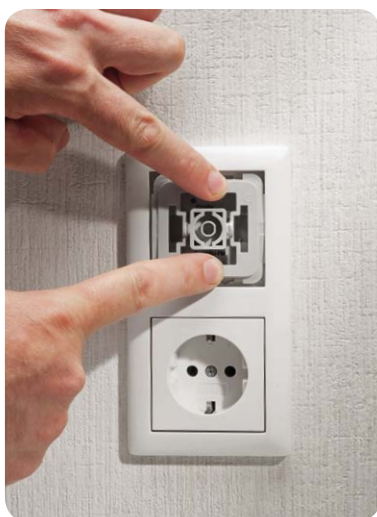
Bild 22: Der Abdeckrahmen des Installationsystems wird aufgesetzt.
