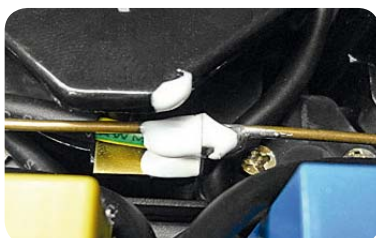
Bild 6: Sauber angelötete und fixierte PE-Leitung
