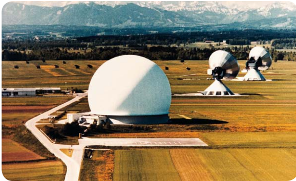
Bild 32: Kommunikationstechnisches Großprojekt – Satelliten-Erde-Funkstelle Raisting
