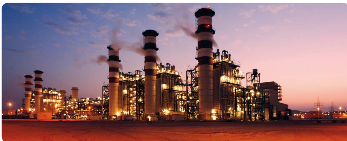
Bild 37: Technologieführer im Kraftwerksbau – das GuD-Kraftwerk mit Meerwasserentsalzungsanlage ist absolute Hightech in der arabischen Wüste.
