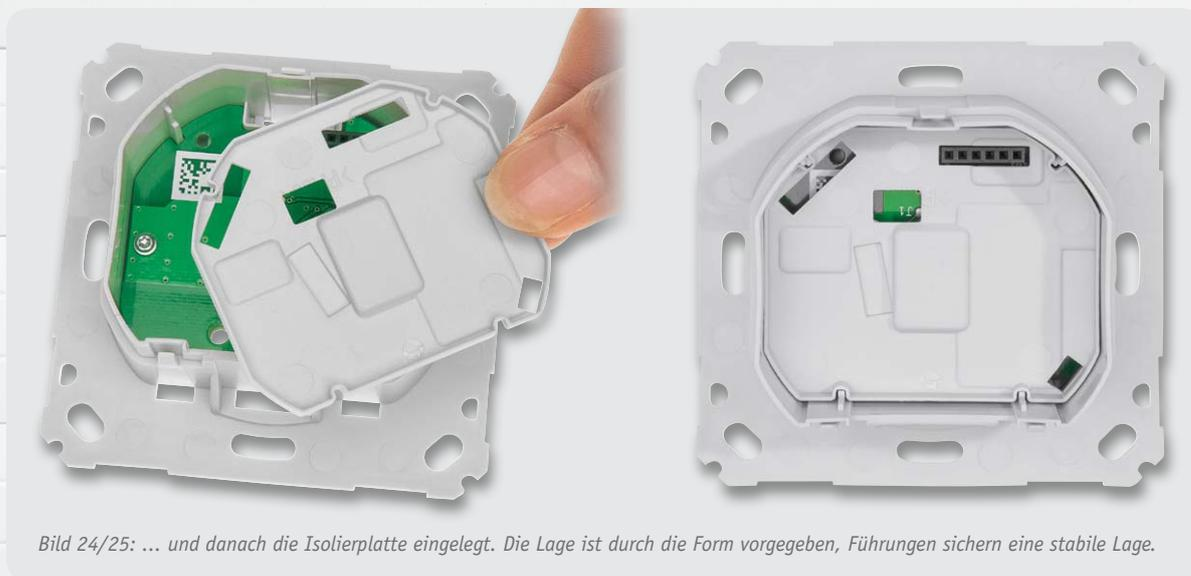
Bild 24/25: ... und danach die Isolierplatte eingelegt. Die Lage ist durch die Form vorgegeben, Führungen sichern eine stabile Lage.
