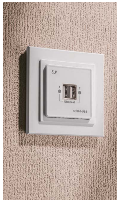
Bild 31: Einsetzen der Frontabdeckung mit Zwischenrahmen
