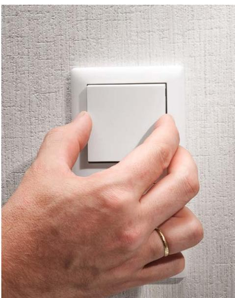
Bild 19: Abschluss der Installation: Einsetzen der Tasterwippe
