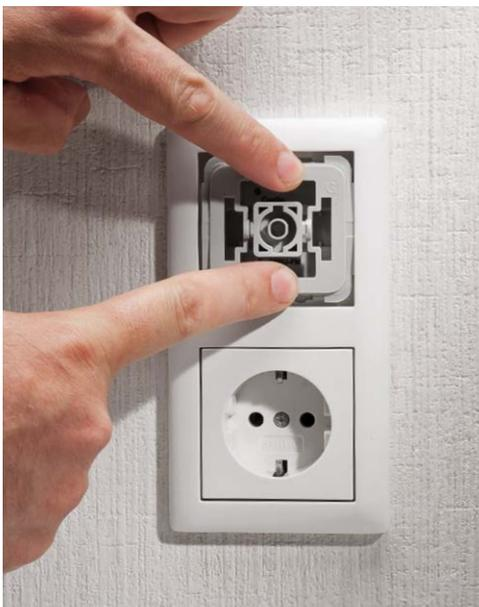
Bild 18: Der Wippenadapter des Installationssystems wird aufgesetzt.
