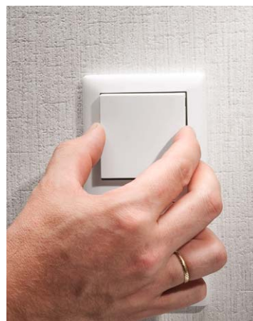
Bild 23: Abschluss der Installation: Einsetzen der Tasterwippe
