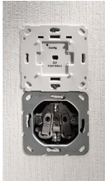
Bild 21: ... wird in die Installationsdose eingesetzt und verschraubt.
