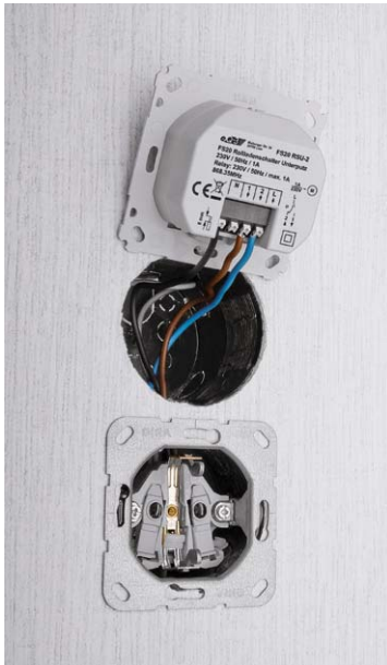
Bild 19: Verdrahtung des FS20 RSU-2
