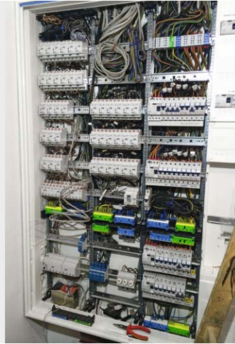
Bild 11: Etwa 60 Aktoren wurden hier in der zentralen Verteilung verbaut.
