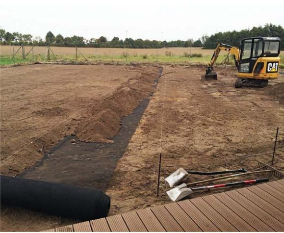
Bild 3: Wasserleitungen, Erdschicht, Maulwurfsperre und anschließend Wasserturbinen bodeneben einbauen. Der Minibagger sparte bei den vielen zu verschiebenden Kubikmetern Erde viel Zeit.
