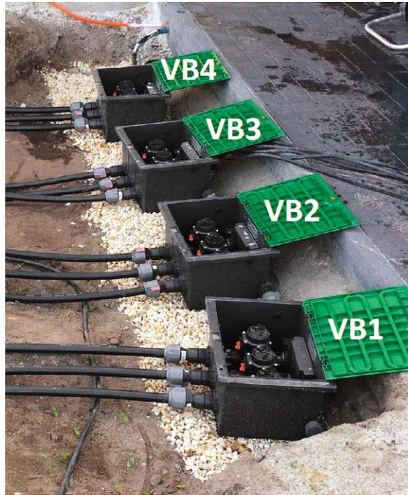
Bild 5: Die Ansteuerung der Turbinen übernehmen 12 Ventile, verteilt auf vier Gardena-V3-Ventilboxen.
