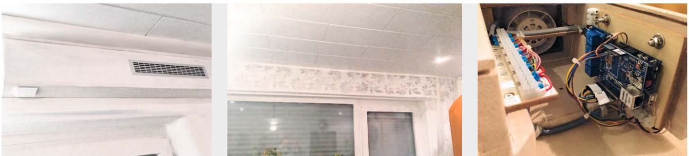
Bild 10: Die Montage des Wärmetauschers und der Steuerungskomponenten
