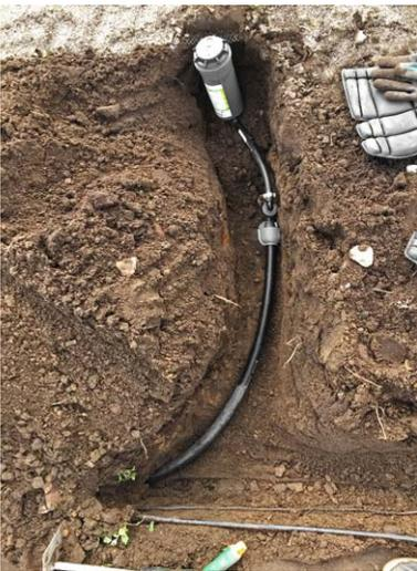
Bild 4: Installation einer Gardena-Wasserturbine T200 mit flexiblem 35-cm-Anschluss-Schlauch, was das Justieren der passenden Turbinenhöhe mit der Erdoberfläche deutlich vereinfacht.“
