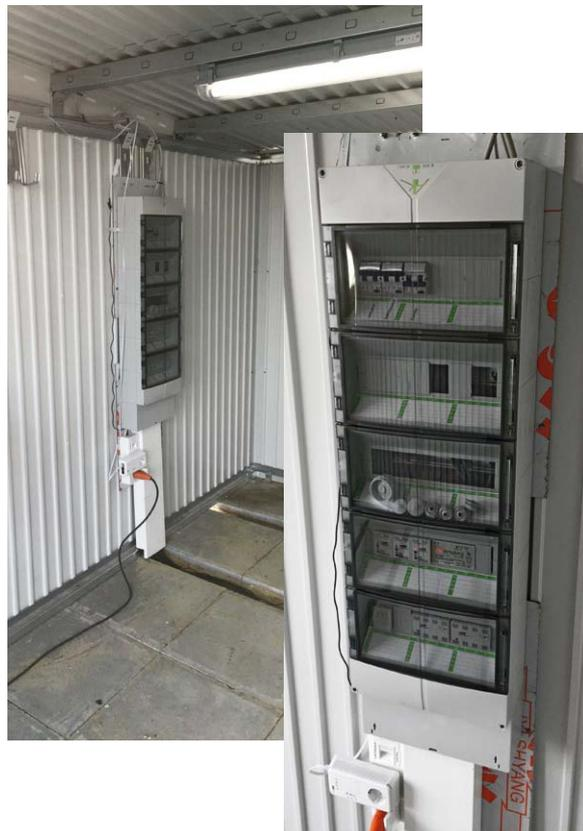
Bild 7: Zusätzlicher Elektroschrank-Verteiler für die HM-Wired-Aktoren, aufgestellt mangels Platz im HWR, nun im Gartenhaus.
