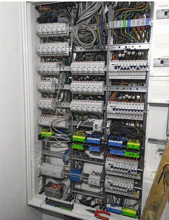
Bild 6: Der Grund für die Auswechslung für den Wired-Aktoren-Verteiler im Gartenhaus: vollbestückter Elektroschrank mit den HM-Wired-Aktoren im Hauswirtschaftsraum.
