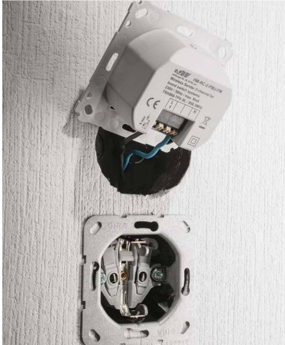
Bild 15: Der fertig verkabelte Aktor ...
