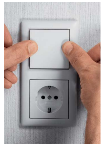
Bild 25: Abschluss der Installation: Einsetzen der Tasterwippe
