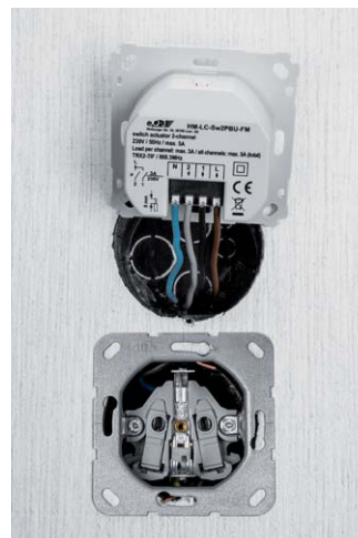
Bild 22: Der fertig verkabelte Aktor ...
