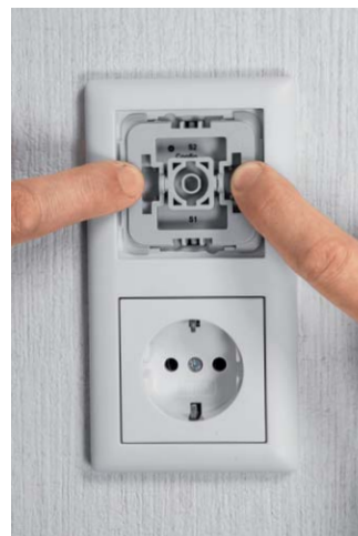
Bild 24: Der Abdeckrahmen des Installationssystems wird aufgesetzt.
