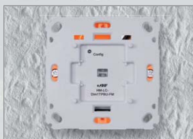
Schritt 4: Schließen Sie den neuen Unterputz-Schaltaktor wie in der Bedienungsanleitung beschrieben an und montieren Sie diesen in der Unterputzdose.
