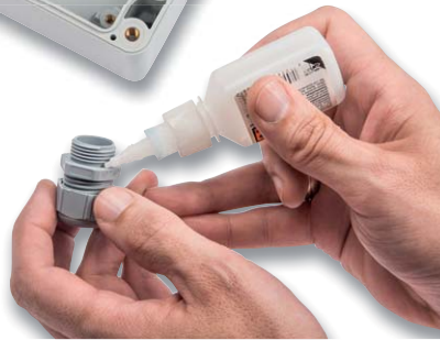
Bild 17: So sind die Kabeldurchführungen am Gehäuse anzubringen.
