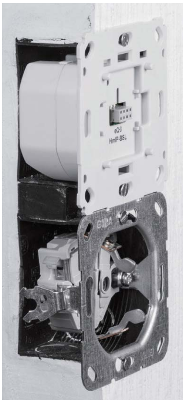
Bild 25: So erfolgt die Montage in eine Unterputzdose.
