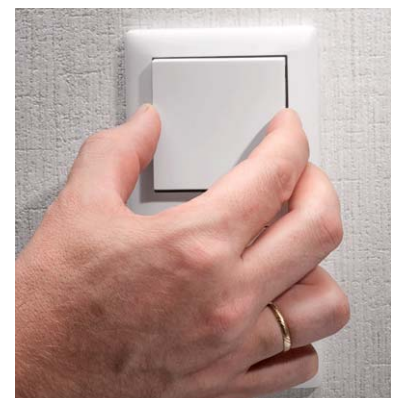
Bild 18: Abschluss der Installation: Einsetzen der Tasterwippe
