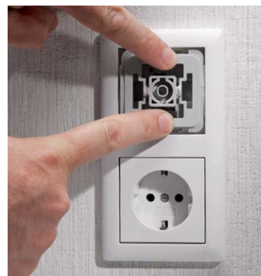
Bild 17: Der Abdeckrahmen des Installationssystems wird aufgesetzt.
