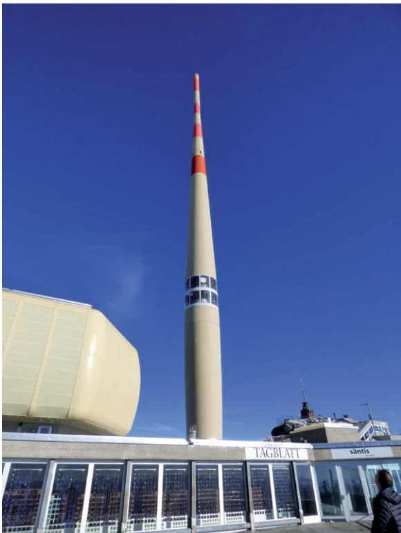
Bild 10: Die höchstgelegene EAN-LTE-Bodenstation befindet sich auf dem Schweizer Säntis in einer Höhe von 2.610 m.
