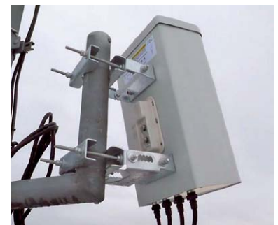
Bild 12: Während die Antennen für terrestrische LTE-Netze überwiegend horizontal ausgerichtet sind, müssen die EAN-LTE-Antennen himmelwärts zeigen.
