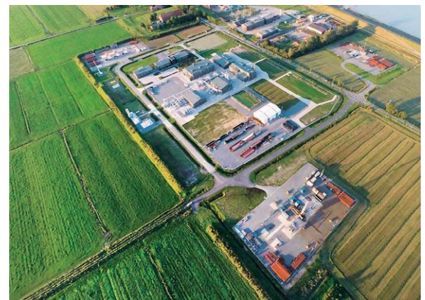
Bild 9: Im ostfriesischen Ort Jemgum soll bis 2023 die weltgrößte Redox-Flow-Anlage auf Polymerbasis entstehen. Bild: EWE
