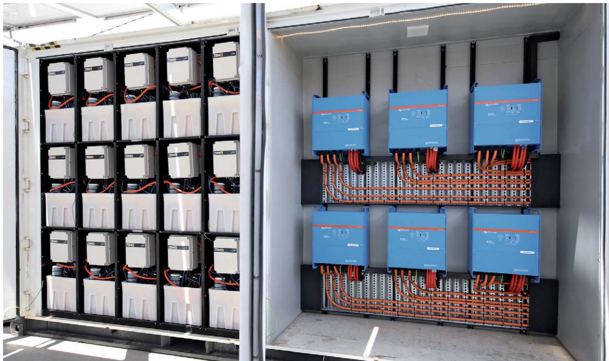
Bild 5: Eine Solar-Redox-Flow-Einheit in der Referenzanlage von Redflow mit 15 ZBM2. Bild: Redflow
