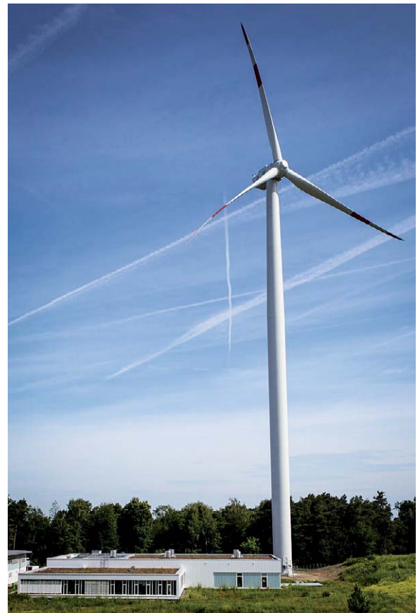
Bild 2: Die komplette Anlage des Windradspeicherprojekts „Redox Wind“. Bild: Fraunhofer ICT
