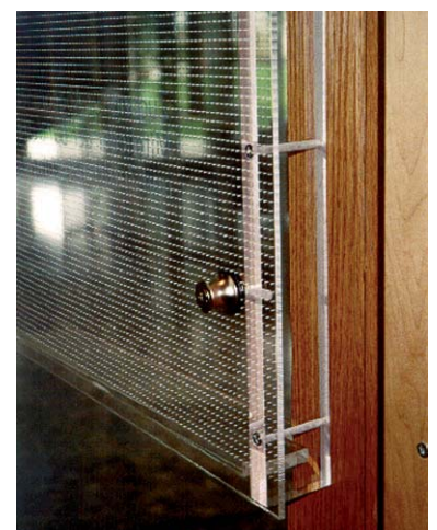
Bild 13: Mikroperforierter Absorber (MPA), bestehend aus einer 5 mm starken Acrylglasplatte mit einer Vielzahl sehr feiner Bohrungen, montiert in einem bestimmten Abstand vor einem schallharten Hintergrund
