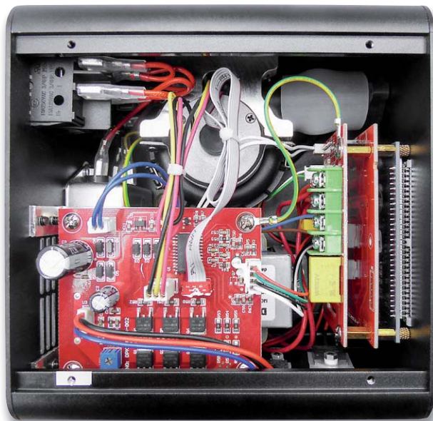
Bild 6: Ein Blick ins Innere zeigt den zwar gedrängten, aber sauberen Aufbau ohne Sicherheitsmängel.
