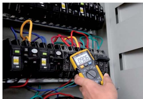
Das robuste Pocket-Multimeter ELV DM100 ist ein universell einsetzbares und einfach zu bedienendes Vielfachmessgerät, das in CAT-III-Umgebungen bis 600 V einsetzbar ist. Neben den Standardmessarten bietet es die Möglichkeit, berührungslos Wechselspannungen, z. B. zur Leitungssuche, zu detektieren.
