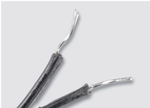
Bild 8: Auftrennen und Abisolieren der Zwillingskabel am Ende
