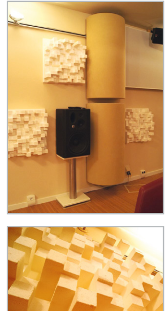
Bild 13: Beispiel für den Einsatz von Diffusoren in einem Abhörraum. Foto: Fa. Harman, 76307 Karlsbad-Ittersbach
