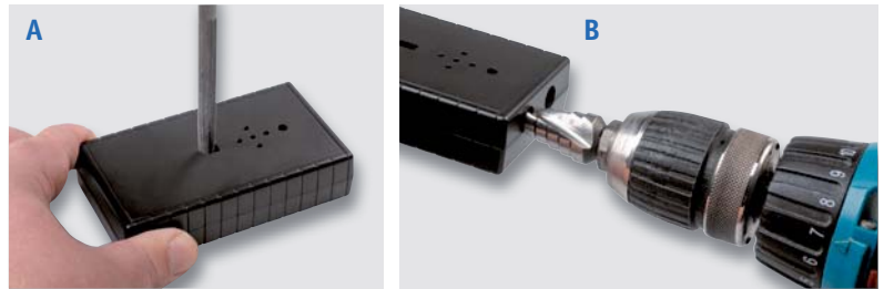
Bild 14: So werden die Bohrungen eingebracht.
