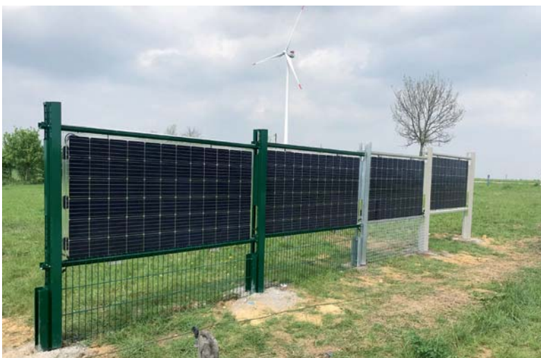
Bild 14: Der bifaciale Solarzaun wird in verschiedenen Zaunfeldformen angeboten. So kann man damit auch das Grundstück umfrieren. Bilder: Next2Sun/solarcarport [7]
