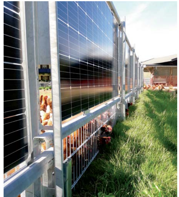
Bild 13: Bifaciale Solarmodule in eine Weideumzäunung integriert, Bild: Next2Sun
