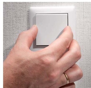
Bild 18: Abschluss der Installation: Einsetzen der Tasterwippe
