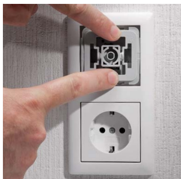
Bild 17: Der Abdeckrahmen des Installations-systems wird aufgesetzt.
