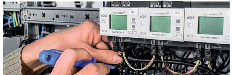
Bild 1: Viele Smart-Home-Geräte bedingen einen fachgerechten Anschluss an das 230-V-Netz.
