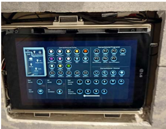
Bild 5: Unterputzeinbau des Tablets im Bad
