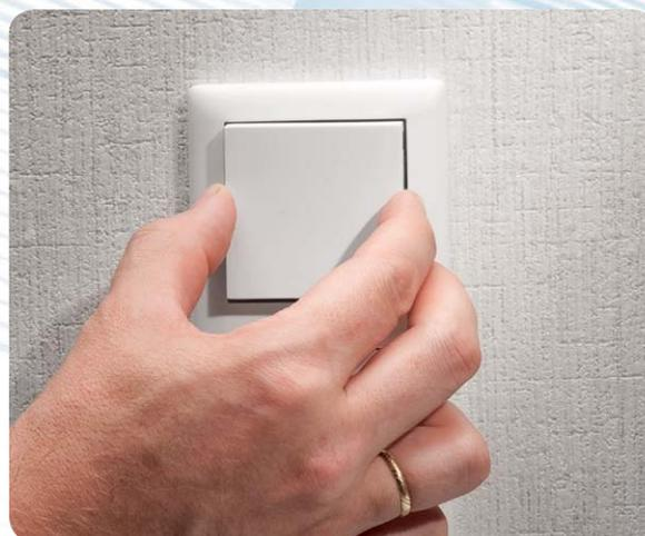
Bild 28: Abschluss der Installation: Einsetzen der Tasterwippe
