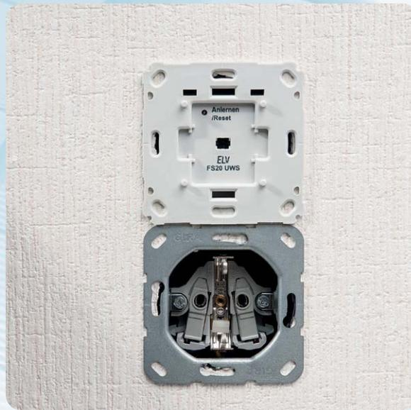
Bild 26: ... wird in die Installationsdose eingesetzt und verschraubt.
