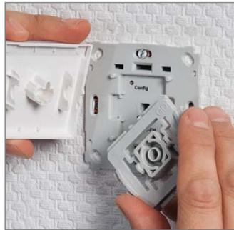
Bild 6: Nun erfolgt die Montage einer 1fach-Wippe auf den separat zu bestellenden Installations-Adapter. Eine Übersicht der verfügbaren Installations-Adapter ist unter Webcode #2054 zu finden.
